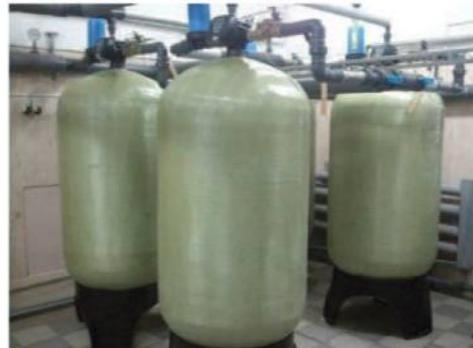
Рисунок 2 – Резервуари очистки води
